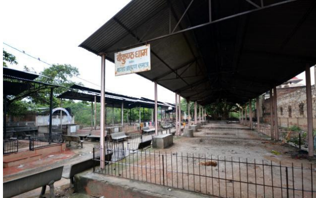
Niemand buiten de Bagad Brahman Samaj, met name Dalits, kunnen deze overdekte plek bij de Chandpole crematieplaats in Jaipur gebruiken. Foto: Rohit Jain Paras
